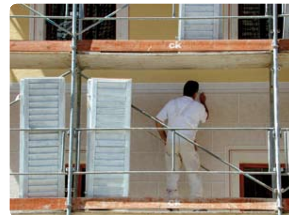
Restoration d'une façade à La Chaux-de-Fonds (rue de l'Industrie 15), 2003.
